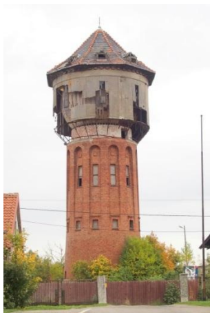
Zdjęcie nr 16. Kolejowa wieża ciśnień, ul. Szwoleżerów
