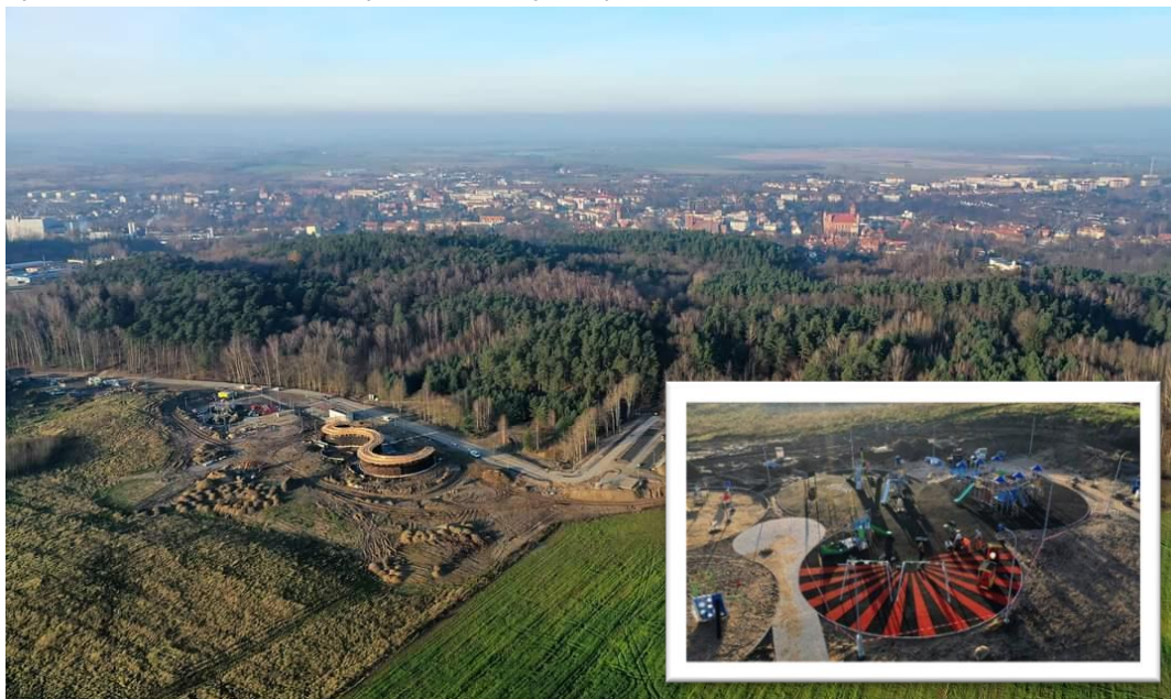
Rysunek 12. Budowa infrastruktury uzdrawiskowej – Etap I
